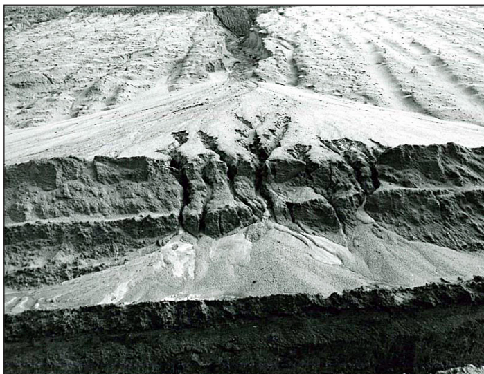
Fot. 1. Erozja wodna na skarpie zwałowiska
