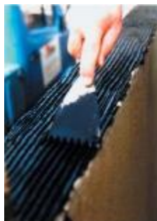
Rys. 5.28. Widok: a) szpachli malarskiej poząbkowanej, b) rozprowadzania kleju za pomocą poząbkowanej szpachli [88]
