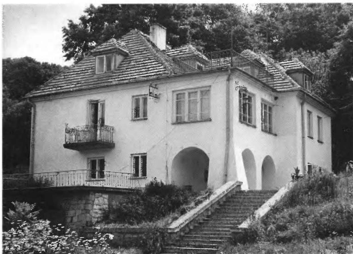
„Dom Pracy Twórczej Politechniki Lubelskiej” w Kazimierzu n/Wisłą (Góra Kwaskowa)
