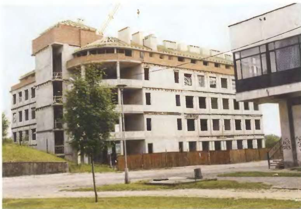
Budynek „Instytutu Inżynierii Środowiska” – w budowie
