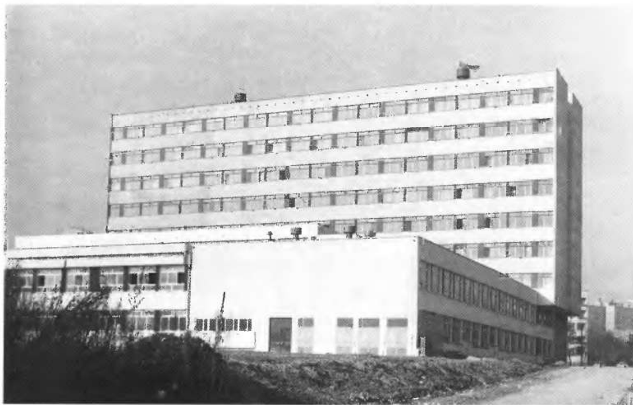
Gmach Instytutu Technologii i Eksploatacji Maszyn (od strony wschodniej)
