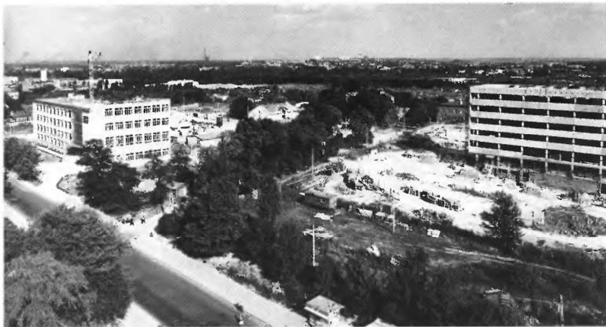
Wielki plac budowy: najbliżej ul. Nadbystrzyckiej – gmach Instytutu Przetwarzania i Użytkowania Energii Elektrycznej, za nim widoczny dźwig obsługujący budowę gmachu Instytutu Technologii i Eksploatacji Maszyn, z prawej strony widoczny gmach Instytutu Inżynierii Budowlanej i Sanitarnej – w budowie
