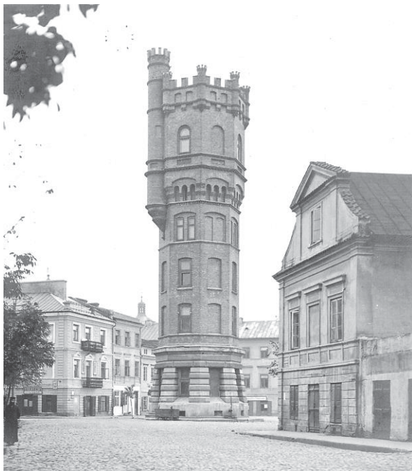
Ryc. 8. Pocztówka z widokiem starej wieży ciśnień na Placu Bernardyńskim (obecny Plac Wolności), zniszczonej w lipcu 1944 r. 78
