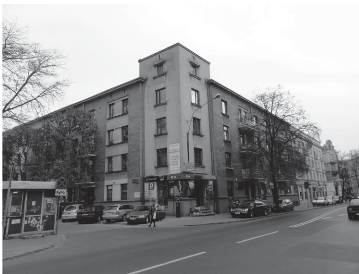
Ryc. 4. Kamienica przy ul. Chopina 8 dzisiaj – fot. własna
